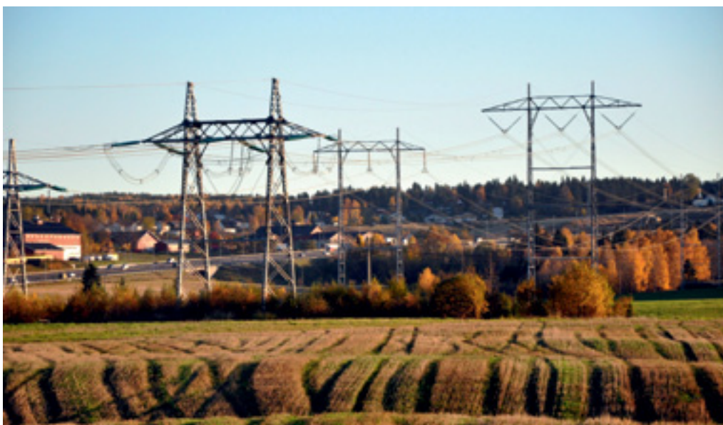
Hvamsletta i Akershus illustrerer trasévalg (lokalisering) for både E6 og høyspentledninger i samme landskap. Foto: Miljøverndepartementet.
