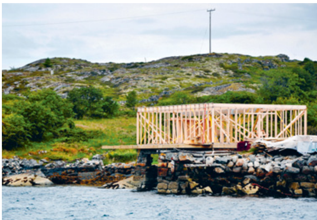
Bygging i strandsonen på Hitra. Foto: Miljøverndepartementet.
