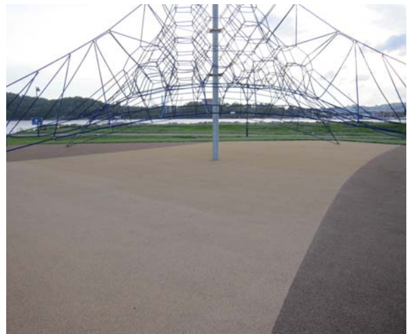
Plasstøpt gummiunderlag i Kristiansand Foto: Sigbrith Sønsteby
