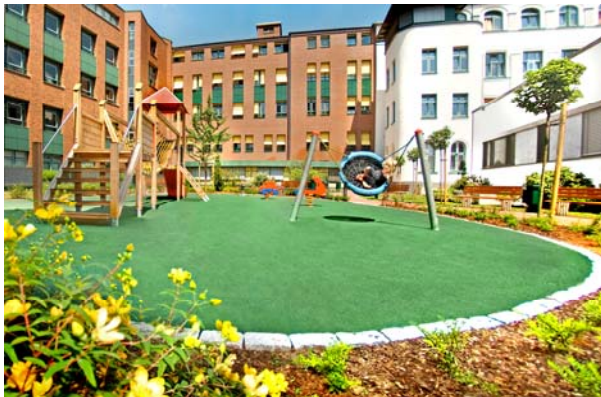
Plasstøpt gummiunderlag krever kanting. Planlegg lekeapparatene nøye – åpning av støpte underlag er kostbart.
