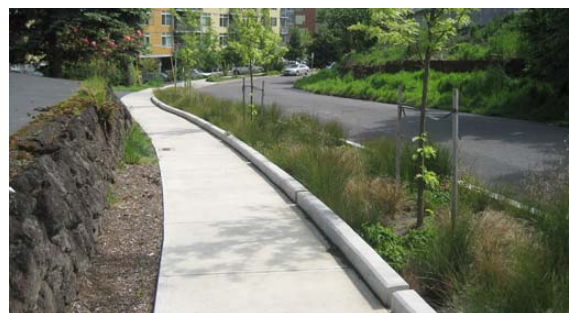
Nyt fortovsanlæg til nedsivning af regnvand i Portland. Foto: Antje Backhaus
