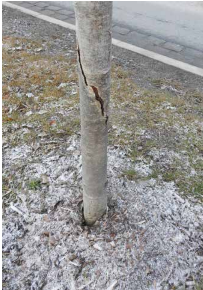
I miljøgata gjennom Sokna sentrum var de fleste trærne døde allerede to år etter planting. Årsak: De var plantet for dypt.
